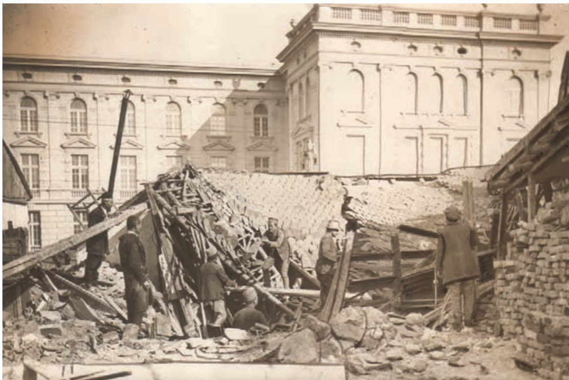
Изградња Техничког факултета
