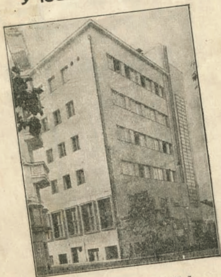
Дом Секције Београд У. Ј. И. А.
